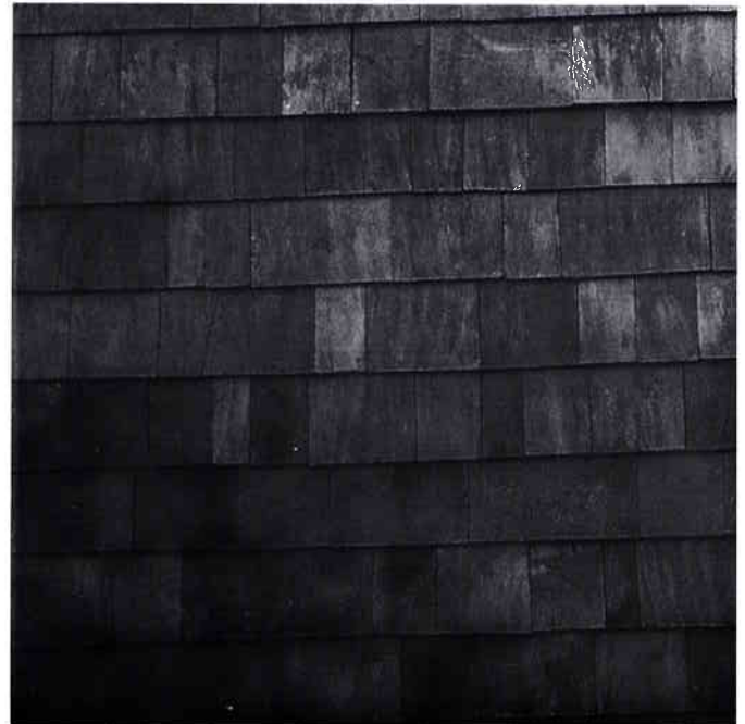
Verschieferung von Wänden und Gaupen in Deutscher Deckung.
