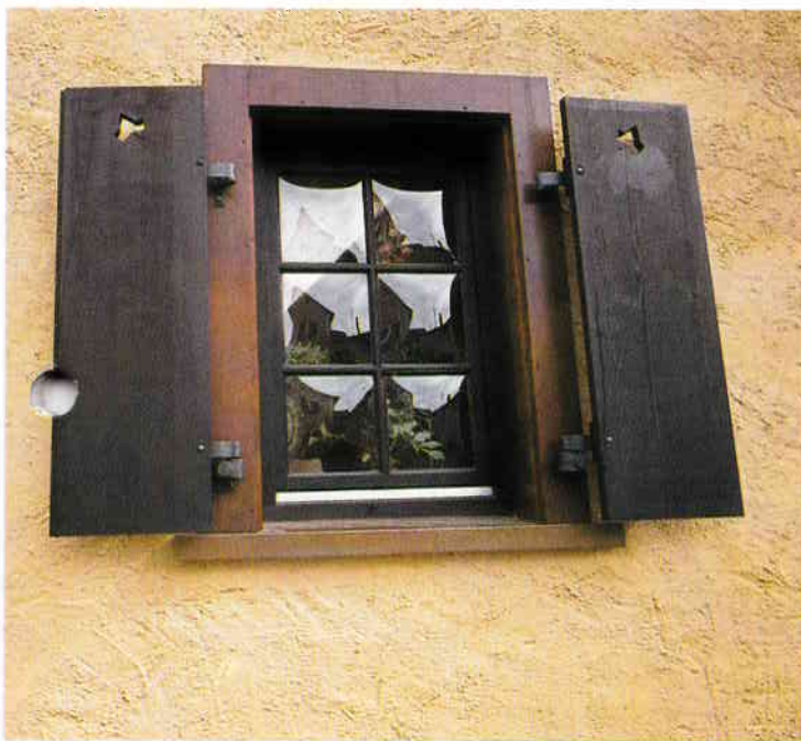
Fenster mit Klappläden, die vom Innenraum aus bedient werden können.
