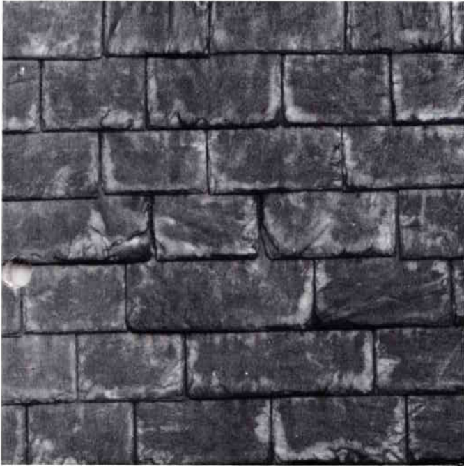
Fassadenverkleidung aus Schiefer in unregelmäßig breiten und hohen Rechteckformaten. Empfohlen für Wände an Neubauten, die besonders stark dem Wetterschlag ausgesetzt sind.
