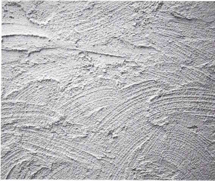
Kellenputz mit dem Quast abgezogen
