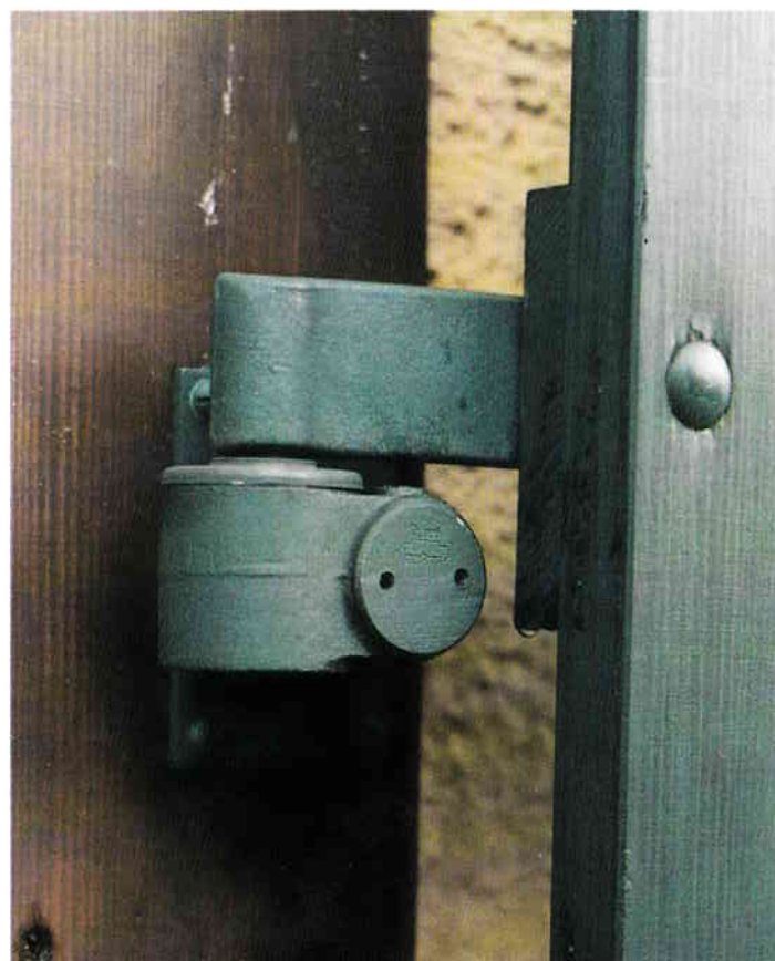
Umlenkgetriebe des Klappladens am Fenstergewände
