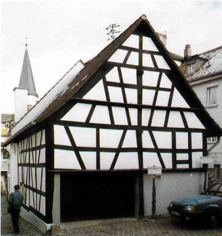
Schöner, gepflegter Fachwerkgiebel eines Nebengebäudes
