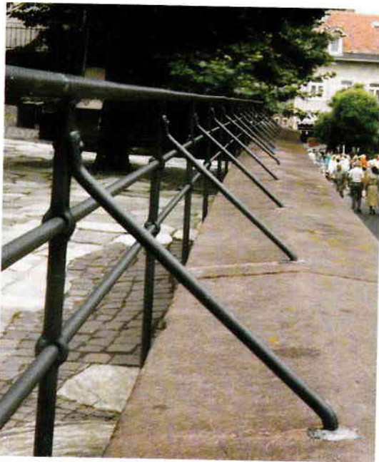
Ein vom Schlosser angefertigtes Geländer mit durchgesteckten Rundstäben. Die dreidimensionale Konstruktion bringt größte Stabilität.
