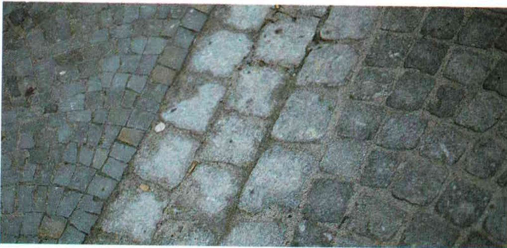
Vom Handwerker vorbildlich ausgeführte Pflasterung aus dem Altstadtbereich von Königstein i.Ts. Fahrbahn, Regenrinne und Fußsteig sind in der Pflasterstruktur voneinander abgesetzt.
