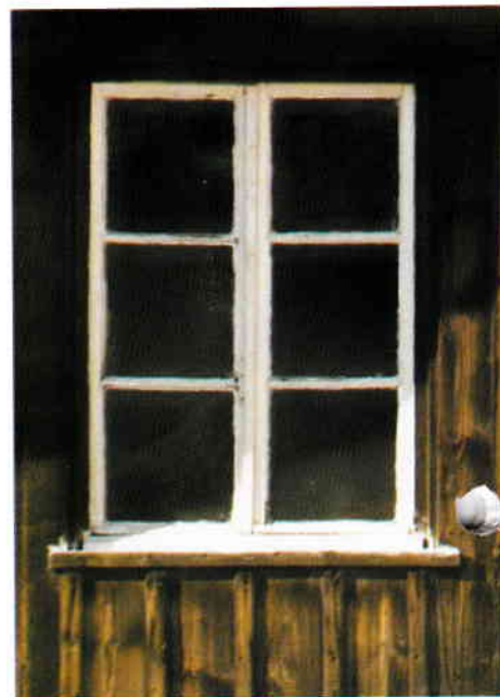
6-scheibiges Fenster mit einfacher Verglasung und schmalen Fenstersprossen, 1 Zoll breit.
