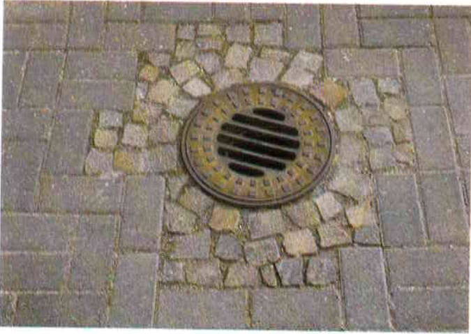
Bodenbelag in einem Fußgängerbereich aus Rechteckbetonpflaster. Die Beipflasterung an den Abflussschacht mit Kleinpflaster aus Porphy.
